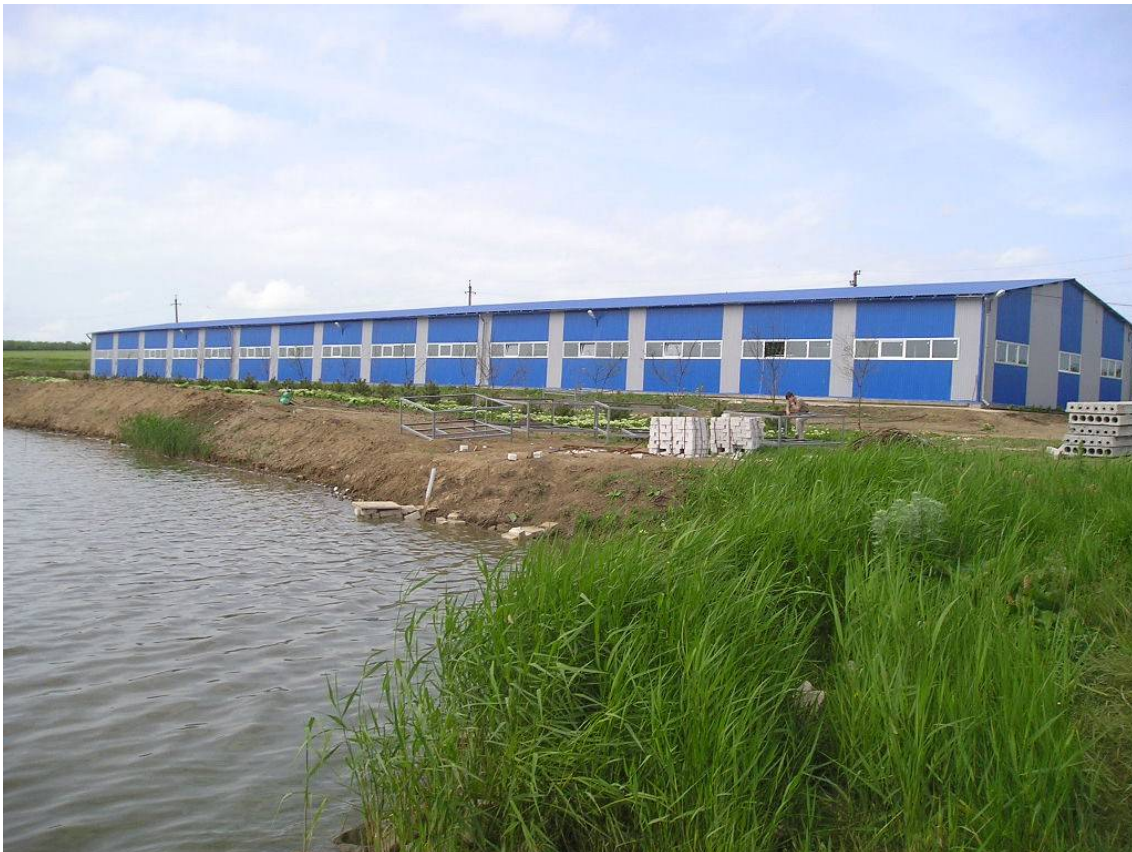
Рисунок 2. Крытый бассейновый модуль для выращивания молоди и товарной рыбы ООО «Одесский осетроводческий комплекс» на берегу Карналиевского водохранилища
